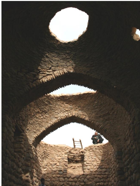
شکل ۹: نمایی از طاق‌ها و فضای داخلی یخچال
