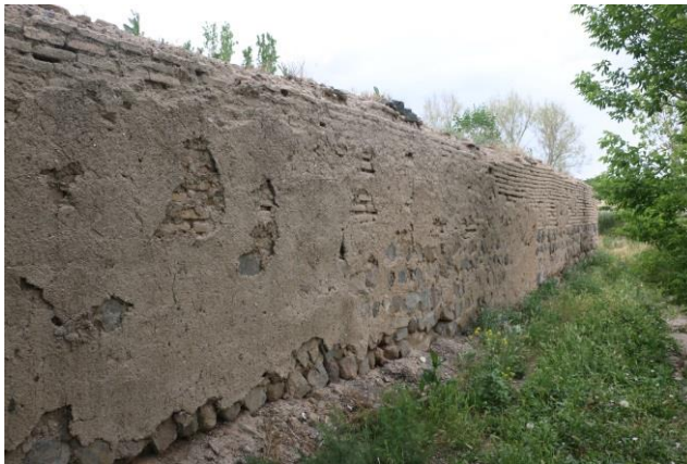
شکل ۱۲: بقایای بنای احتمالاً یخچال در جنوب ایستگاه راه آهن
