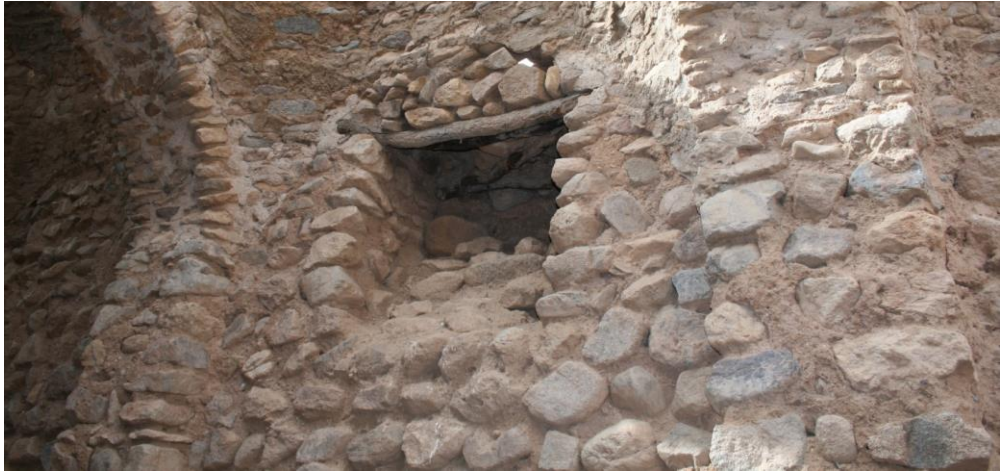
شکل ۸: مصالح سنگی دیوارها، توپزه‌ها و طاق‌ها
