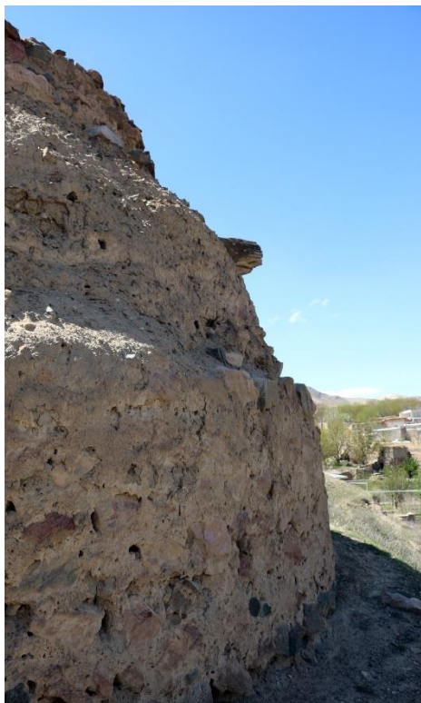
شکل ۵: دیوار بیرونی گنبد و پوشش کاه گل روی آن
