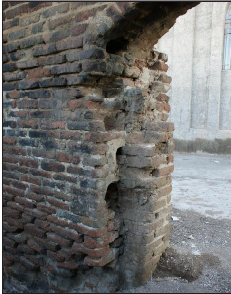
شکل شماره ۱۳: جزئیات ورودی و محل قرارگیری کلون درهای اتاق‌های طرفین سردر اصلی (عکس از نوراللهی)
