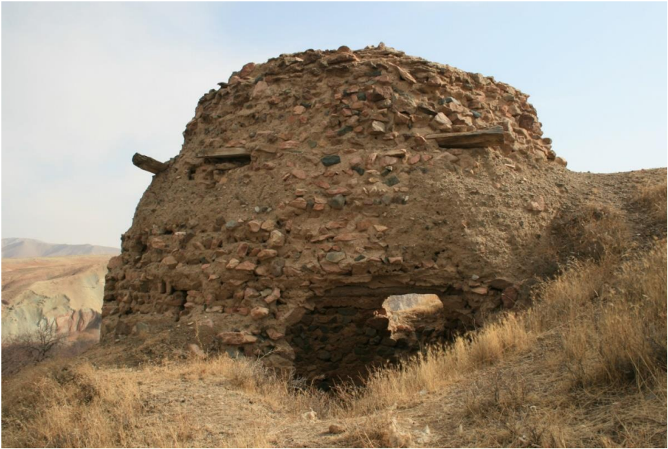
شکل ۲: نمایی از بخش بیرونی یخچال قلعه جوق
