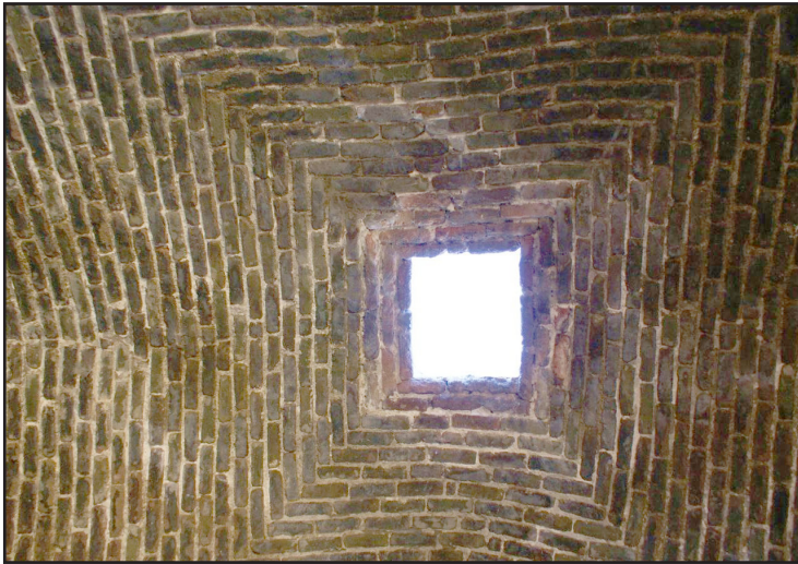
شکل شماره ۷: نورگیر سقف کاروانسرای نیک‌پی (عکس از نوراللهی)
